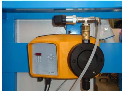
En la salida del equipo está instalado un caudalímetro de alta resolución (hasta 3 mililitros) para control del envío de producto al lubricador.
