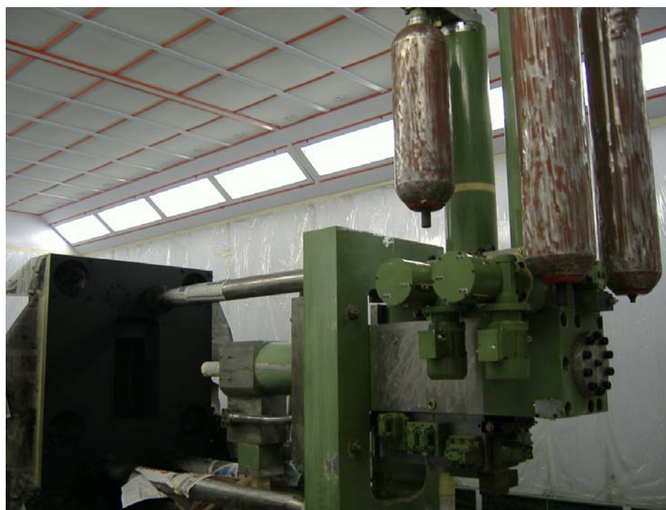
CABINA DE PINTURA - INTERIOR
